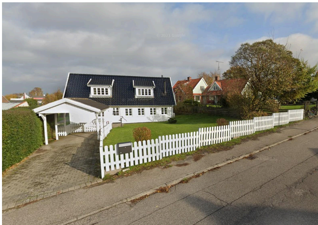
Matrikelnummer 54 (Kælderbjergvej 5). Nr. 7 ses i baggrunden (2024).
