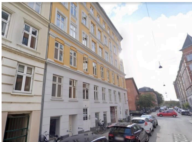
Helgesensgade nr. 14. Nr. 13 på modsatte side er revet ned.
