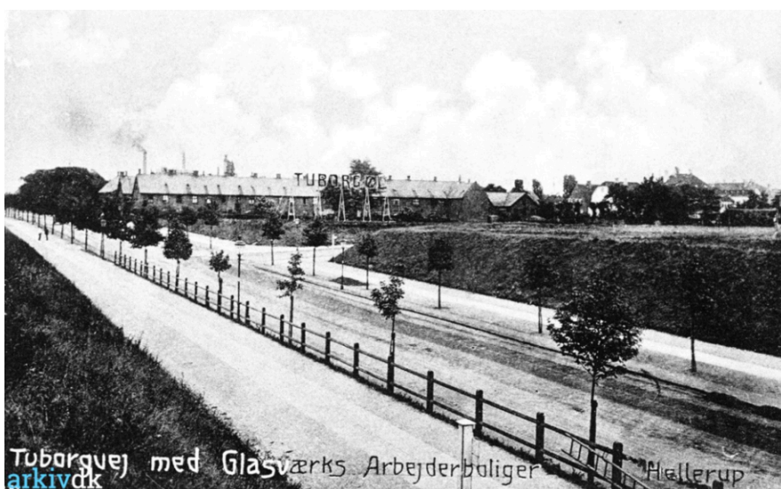
Glasværkets arbejderboliger på Tuborgvej.
